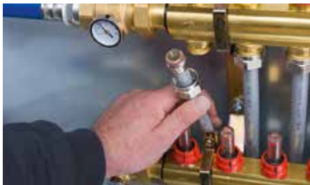
Рис. 1. Наденьте гайку компрессионного фитинга на трубу, вставьте фитинг в трубу до упора.
